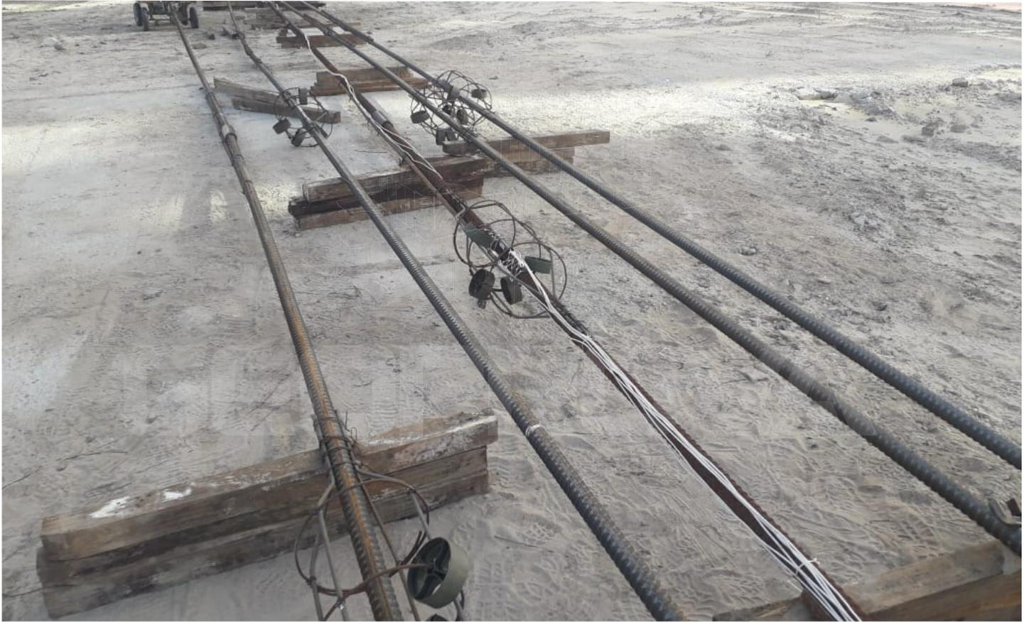
A [prova de carga estática](#) permite a avaliação da capacidade de carga e dos deslocamentos das estacas quando submetidas a um carregamento e é uma ferramenta de grande potencial para a racionalização dos projetos de fundação. Esse ensaio pode fornecer ainda mais informações quando as estacas são instrumentadas em profundidade.
