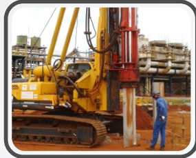
Ensaio de carregamento dinâmico (PDA)
