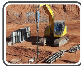
Ancoragem para provas de carga (SAP)
