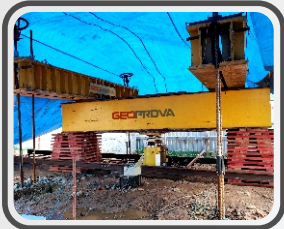
Prova de carga estática em estacas (PCE)
