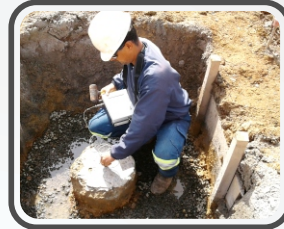
Ensaio de integridade (PIT)
