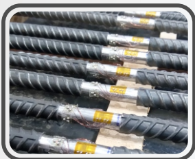
Instrumentação de estacas em profundidade
