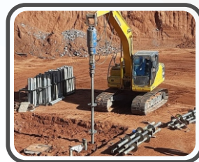
Ancoragem para provas de carga (SAP)
