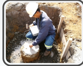
Ensaio de integridade (PIT)
